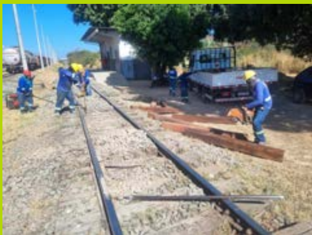
Manutenção de via com substituição de dormentes
