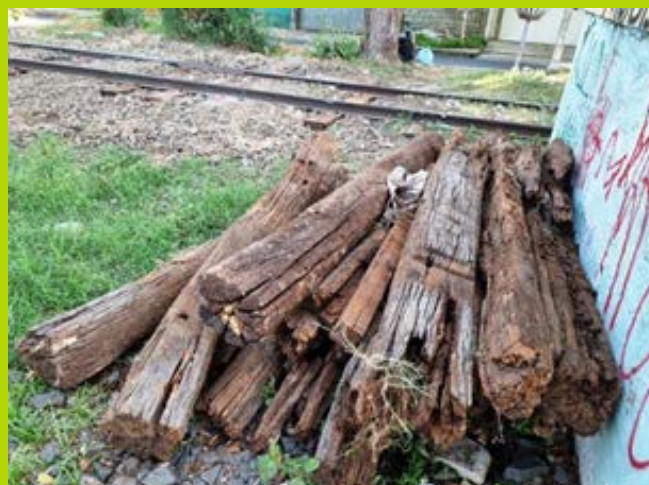
Dormentes substituídos Estação Renascença
