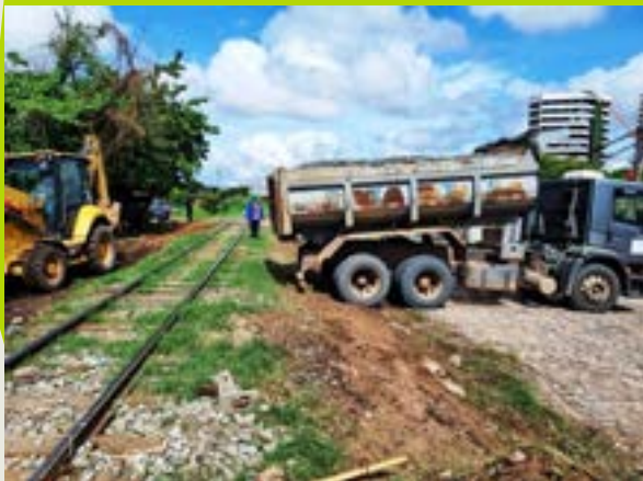
Fornecimento e transporte de brita Estação Goiás
