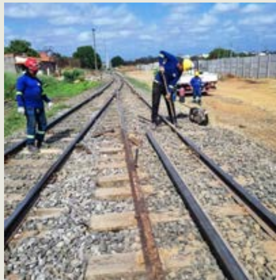
Substituição de trilhos – Boa Esperança
