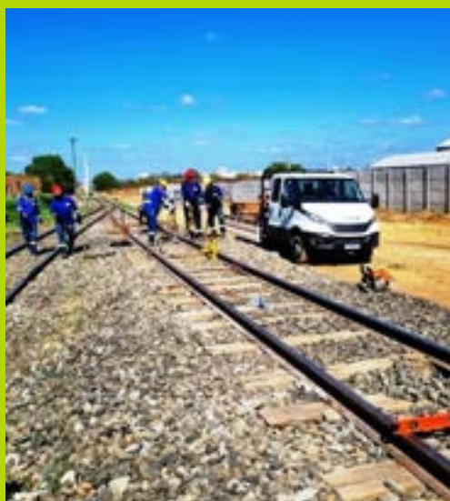
Nivelamento de juntas Estação Boa Esperança
