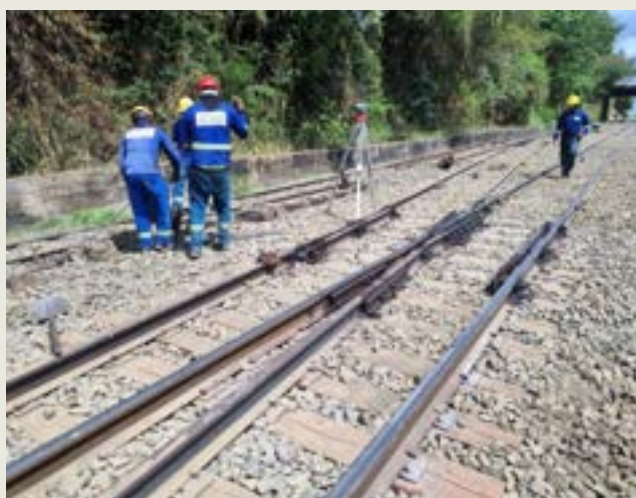
Implantação de 02 AMVs – Estaca 492
