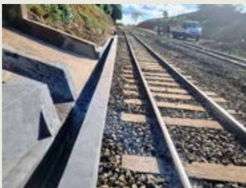
Construção de canaleta – Estação Boa Esperança
