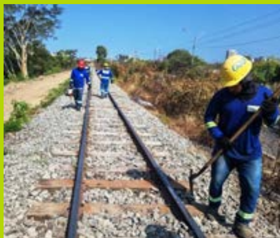
Nivelamento e acerto do lastro Estação São João
