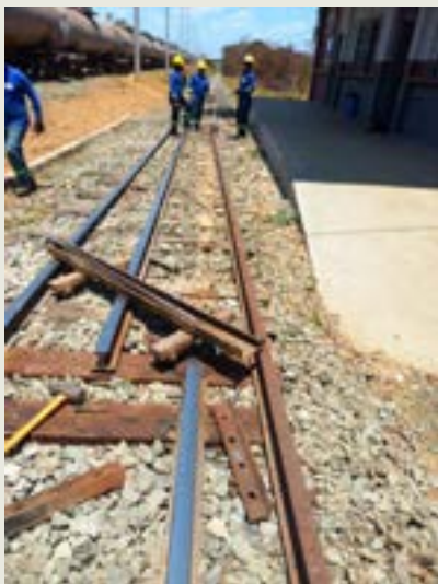
Substituição de trilhos – São João
