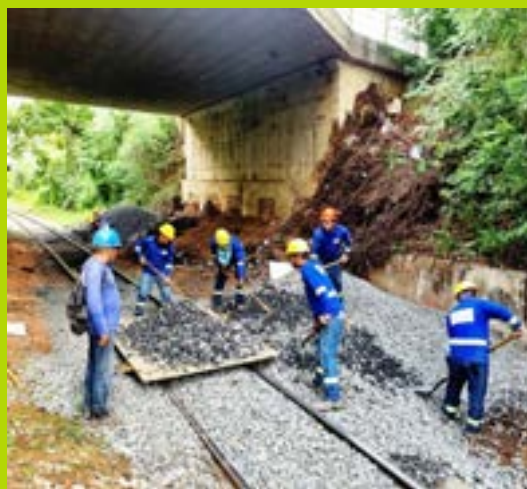
Lastramento de via – Mafuá
