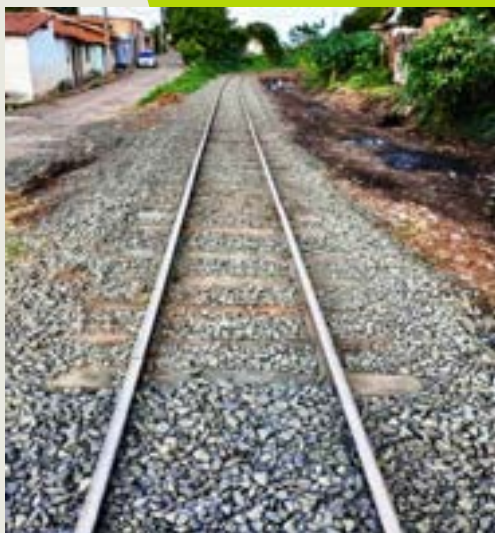
Nivelamento e acerto do lastro – Ilhotas
