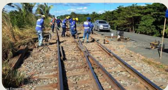
Manutenção em Aparelho de mudança de via – Estação São Joao
