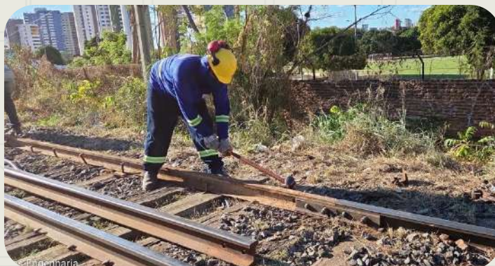
Substituição de trilhos
