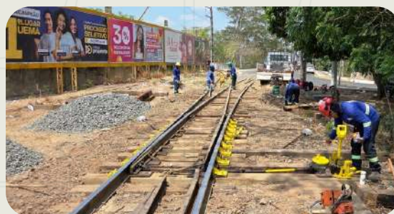
Lastramento e nivelamento de Aparelho de mudança de via – Estação Matinha
