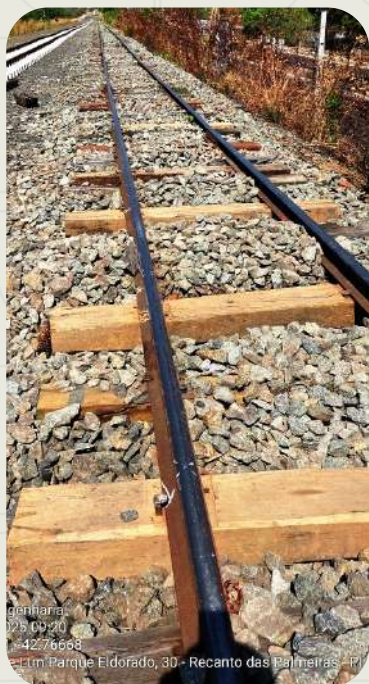
Substituição de dormentes de madeira, Quadramento e reespaçamento
