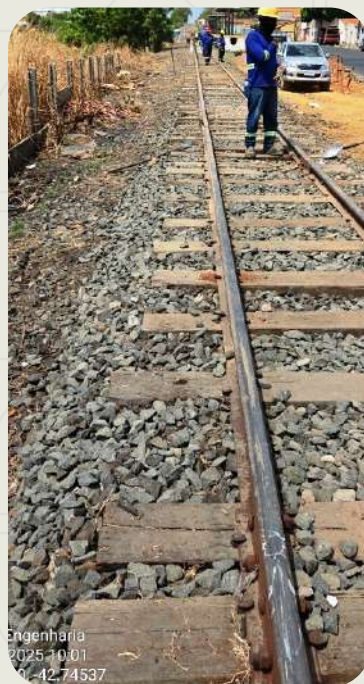
Substituição de dormentes de madeira, Quadramento e reespaçamento
