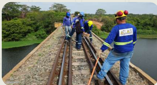
Nivelamento de juntas
