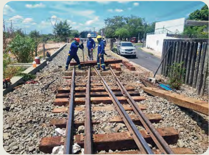
Substituição de dormentes especiais de AMV.
