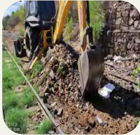
Remoção de entulho com utilização de máquina.
