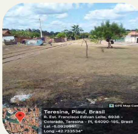
Remoção dos resíduos provenientes da capina e roço..
