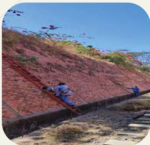
Limpeza do talude (Estação Frei Serafim).
