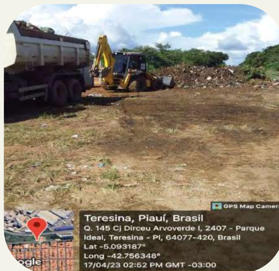
Utilização de máquina e caçamba basculante para remoção dos resíduos.
