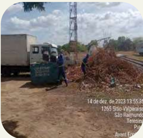
Remoção de resíduos com utilização de container estacionário.
