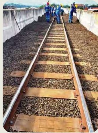
Nivelamento de via – Matinha.
