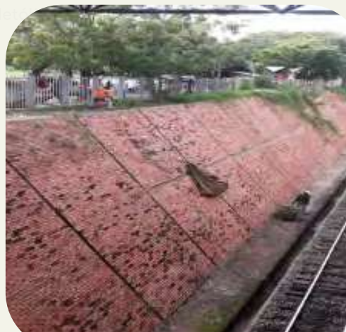
Liçamento de resíduos proveniente do roço realizado no talude.
