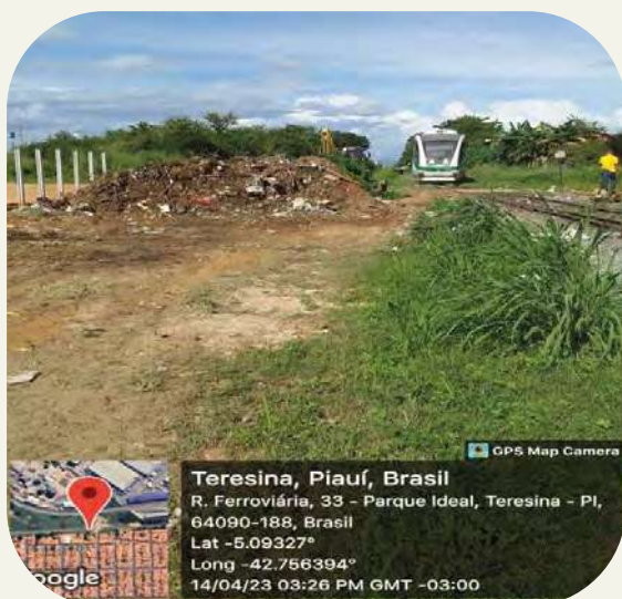
Remoção do lixo originário do descarte irregular pela população próximo aos trilhos.
