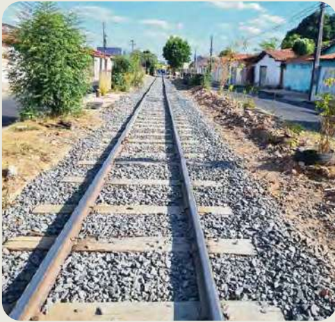
Nivelamento de via – Renascença.
