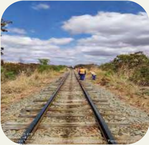
Capina na via permanente.
