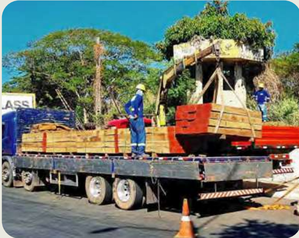
Carga, transporte e descarga de dormentes.
