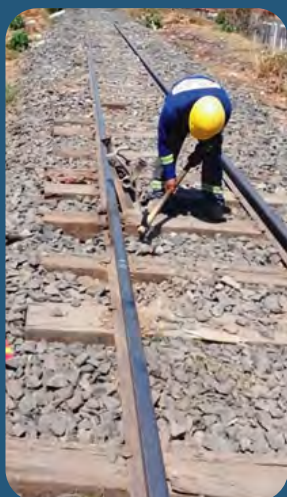
Nivelamento de juntas - Ihotas.
