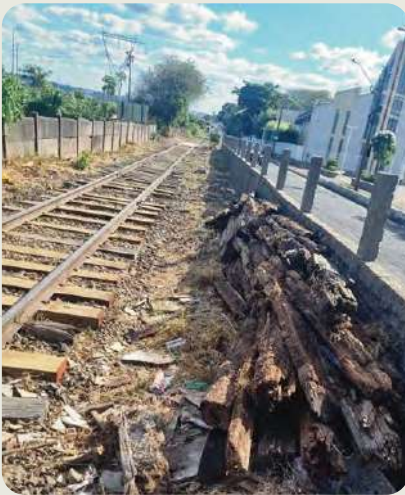
Substituição de dormentes E 655 – Parque Ideal.
