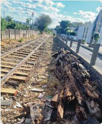
Substituição de dormentes E 655 – Parque Ideal.
