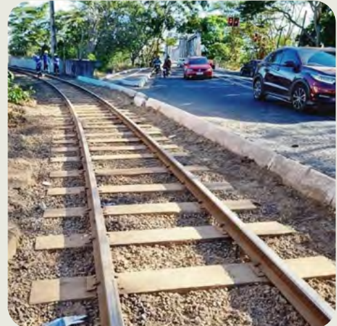
Substituição de dormentes de madeira.
