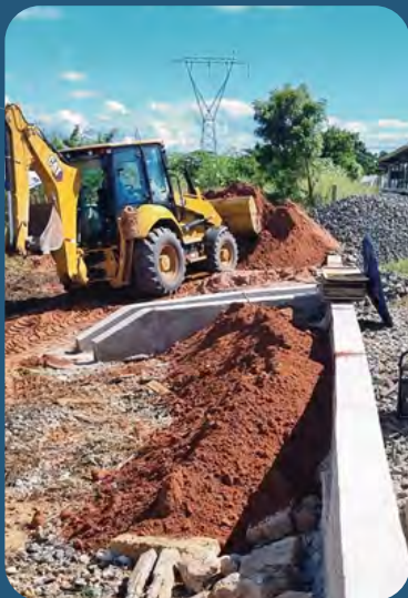
Construção de Muro de contenção.
