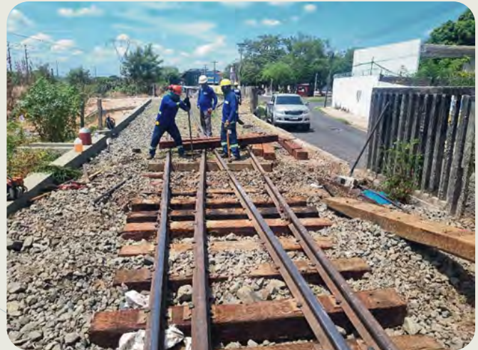
Substituição de dormentes especiais de AMV.
