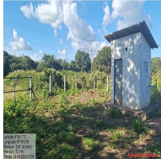
Foto 02: Local da implantação do reservatório de 10m³ sobre base pré-moldada de 8,00m;
