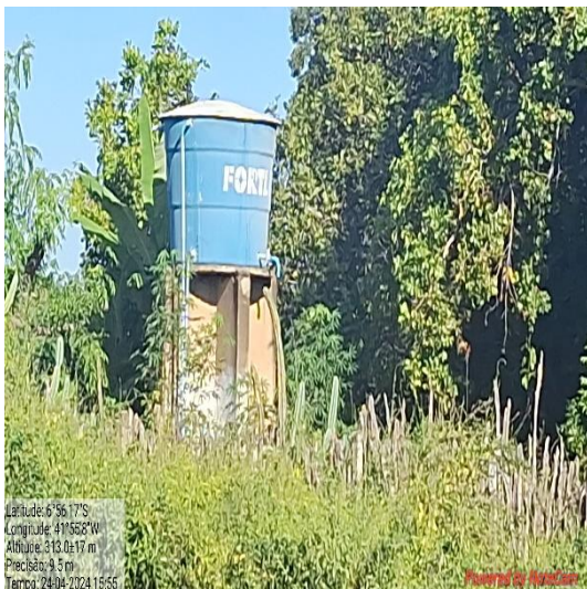
Foto 03: Reservatório existente que não atende à demanda total da localidade;
