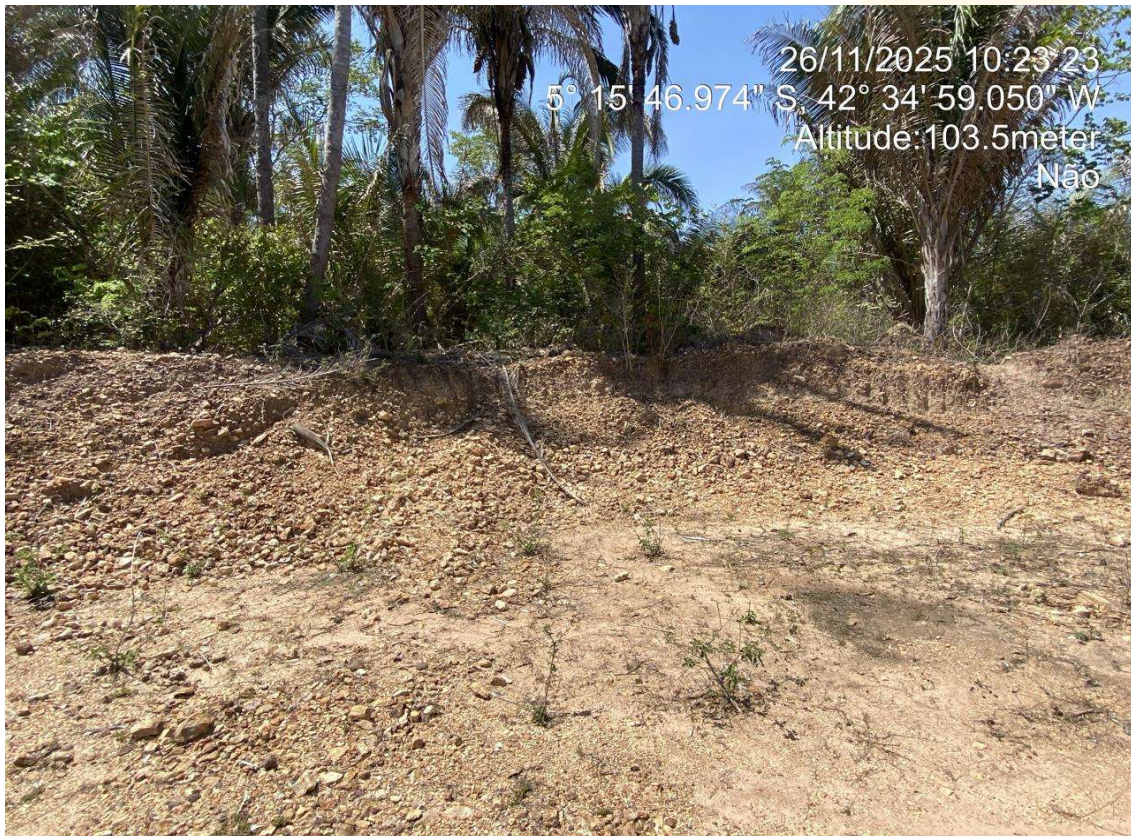
Jazida de material 01
