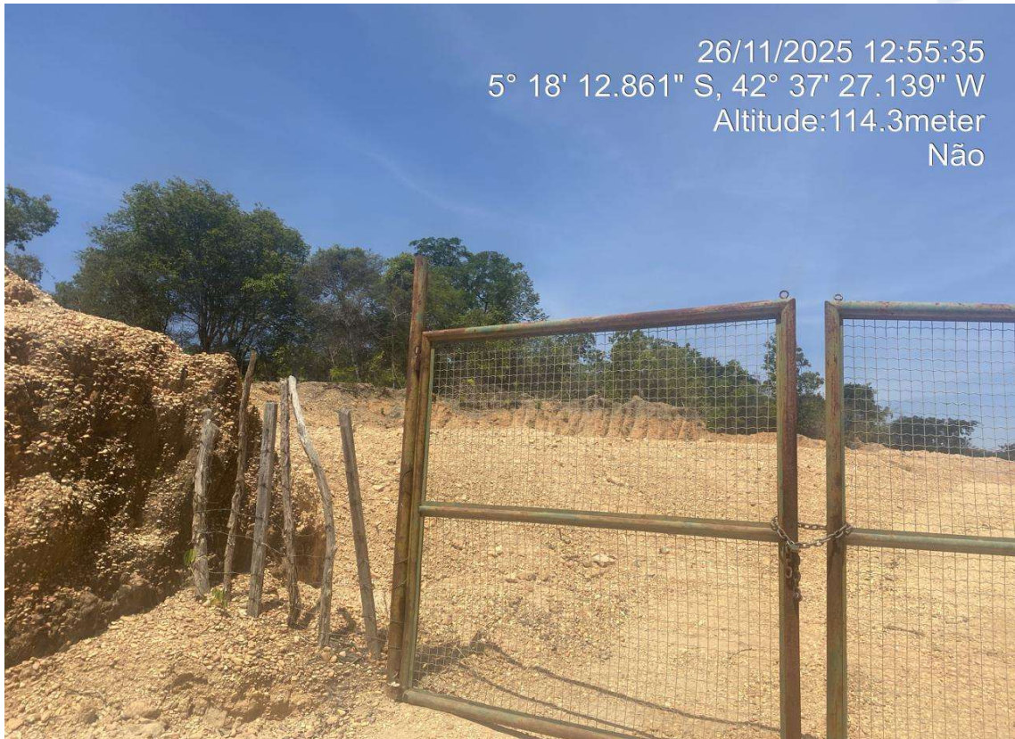
Jazida de material 02
