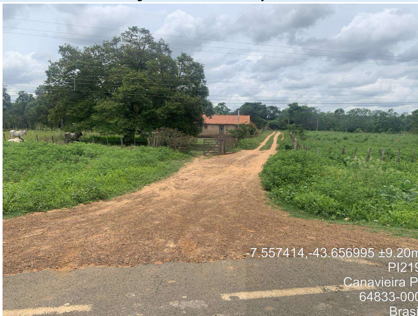
Imagem 01 - Início da Rua Projetada 01
