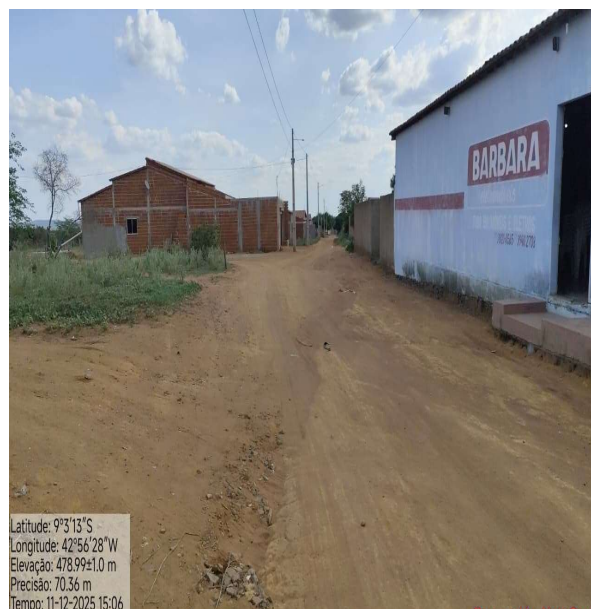
Rua Projetada 02 - Início
