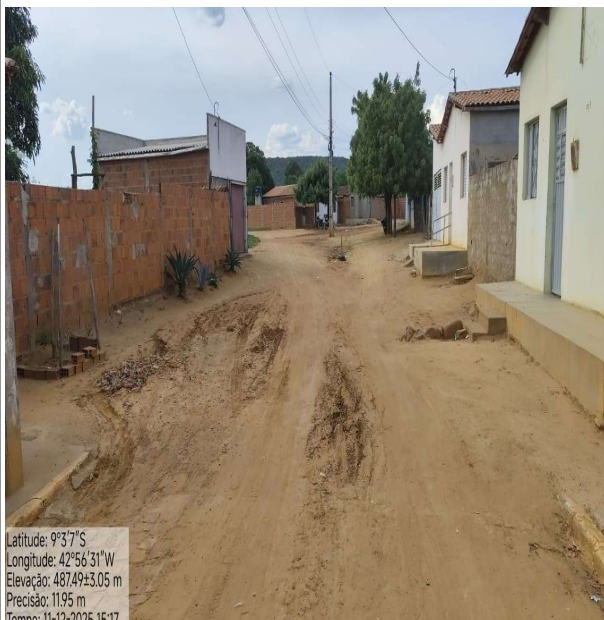
Rua Projetada 01 - Início
