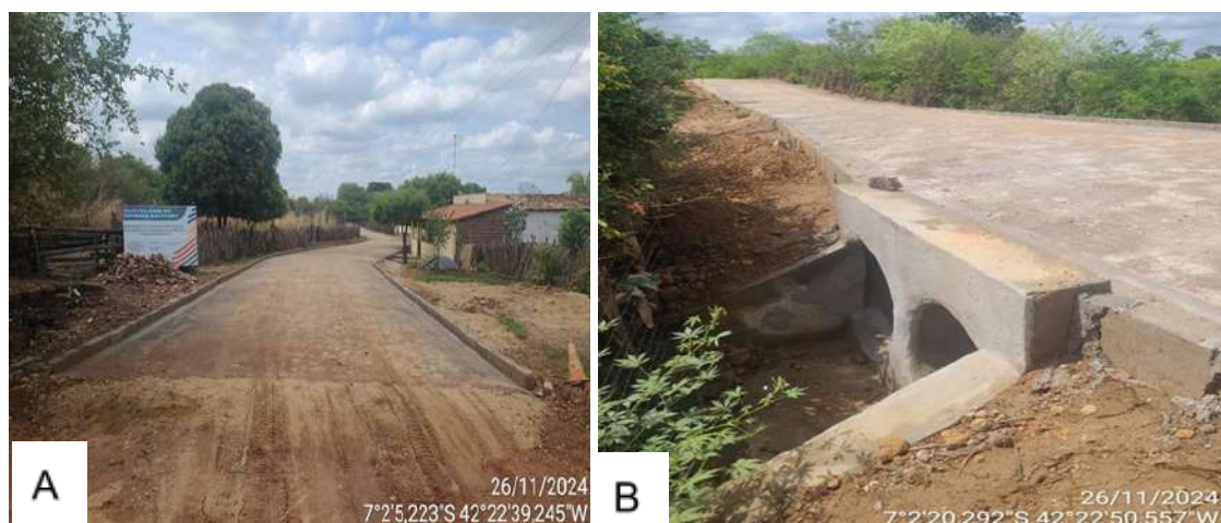
Figura 72(A e B) - Pavimentação Poliédrica nas Localidades Brejinho e Exú zona rural do Município de Oeiras-PI.
