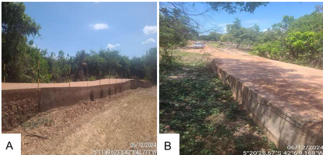
Figura 89 (A e B) - Passagens Molhadas na zona rural do Município de Alto Longá-PI.
