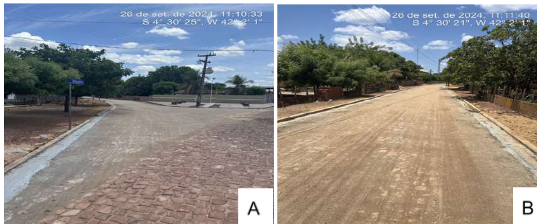
Figura 67 (A e B) - Pavimentação Poliédrica na Localidade América na zona rural do Município de Capitão de Campos-PI.
