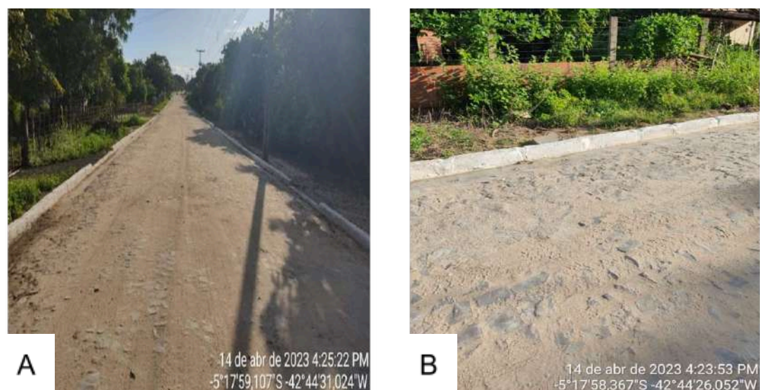
Figura 47 (A e B) - Pavimentação em Paralelepípedo no Assentamento 17 de Abril, zona rural do Município de Teresina-PI.
