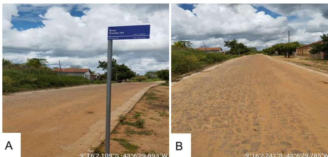
Figura 44 (A e B) - Pavimentação em Paralelepípedo nas Localidades Baixa Grande e Cupins, zona rural do Município de Jurema-PI.
