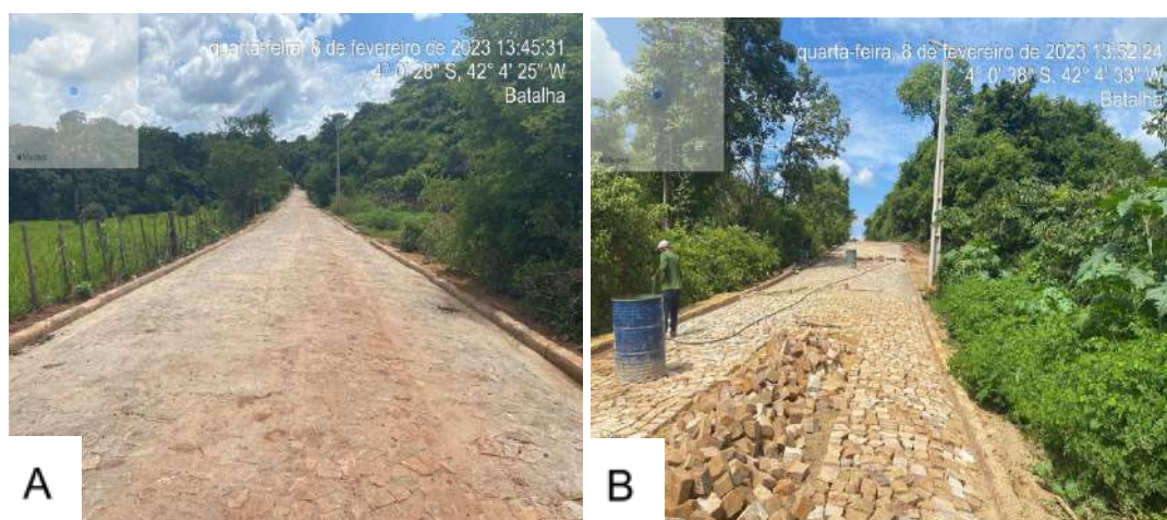
Figura 46 (A e B) - Pavimentação em paralelepípedo na Localidade Exú, zona rural do Município de Batalha-PI.
