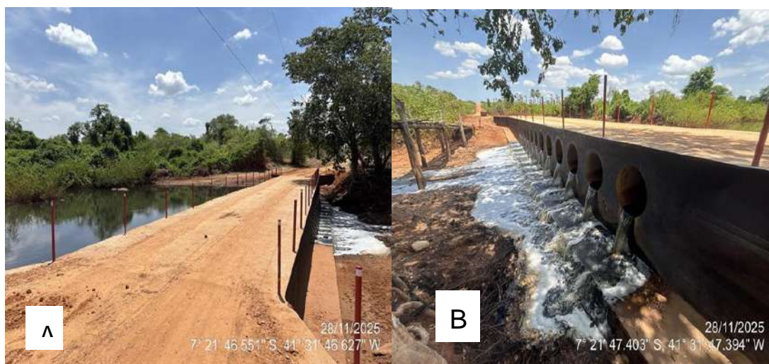
Figura 77 (A e B) Implantação de Passagem Molhada na Localidade Piçarra, zona rural do Município de Itainópolis-PI.
