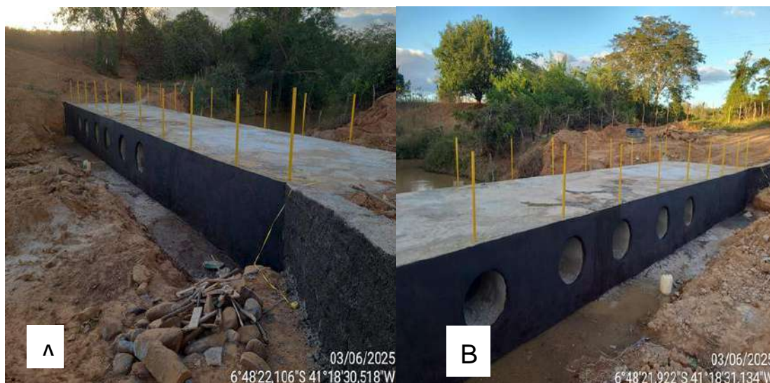
Figura 75 (A e B) - Implantação de Passagem Molhada na Localidade Guariba Velha, zona rural do Município de São Luís-PI
