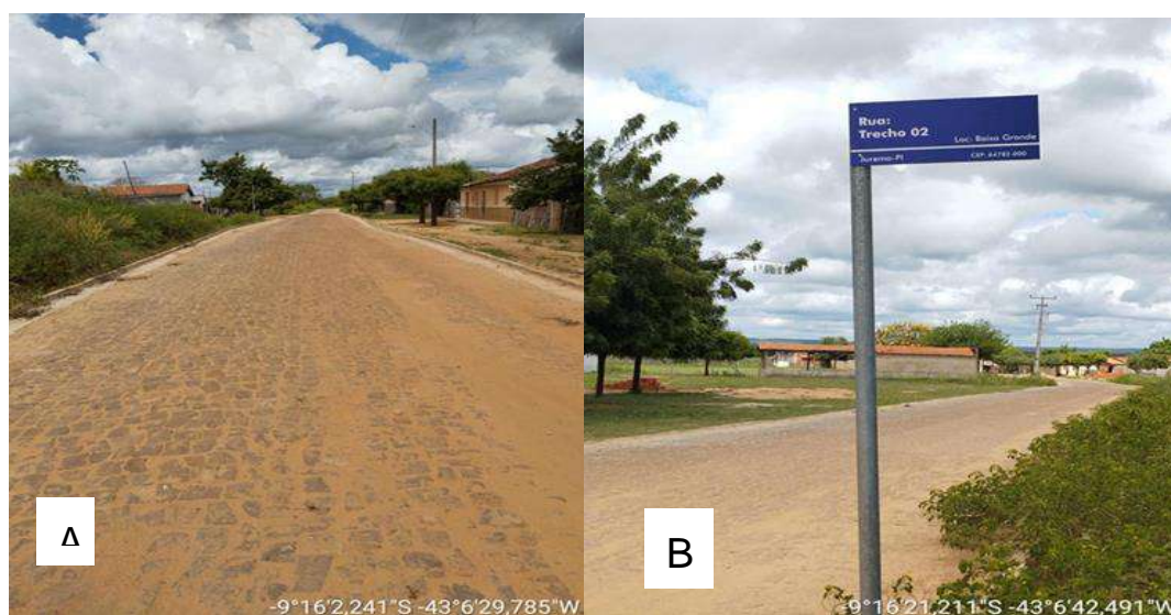
Figura 68 (A e B) - Pavimentação Poliédrica nas Localidades Baixa Grande e Cupins, zona rural do Município de Jurema-PI.
