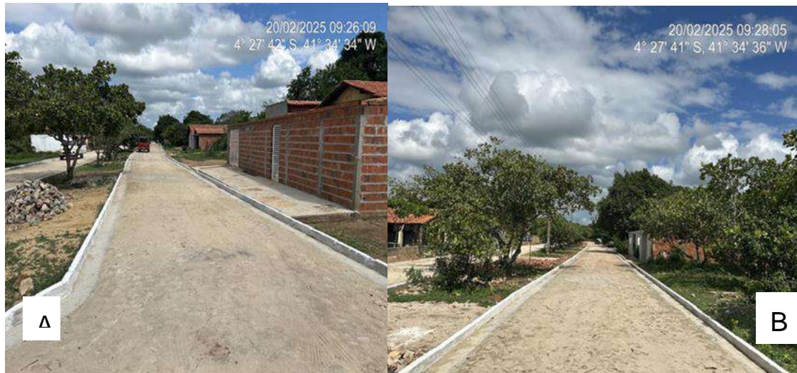
Figura 61 (A e B) - Pavimentação Poliédrica na Localidade Lagoa do Sucuruju, zona rural do Município de Pedro II-PI.
