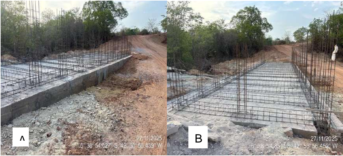
Figura 70 (A e B) - Implantação de duas Passagens Molhadas na Localidade Quilombo Caldeirão, zona rural do Município de Amarante-PI.
