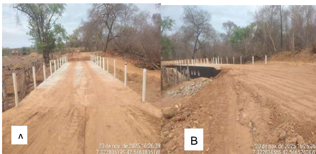
Figura 76 (A e B) - Implantação de Passagem Molhada na Localidade Riacho Fundo, zona rural do Município de São Francisco do Piauí-PI
