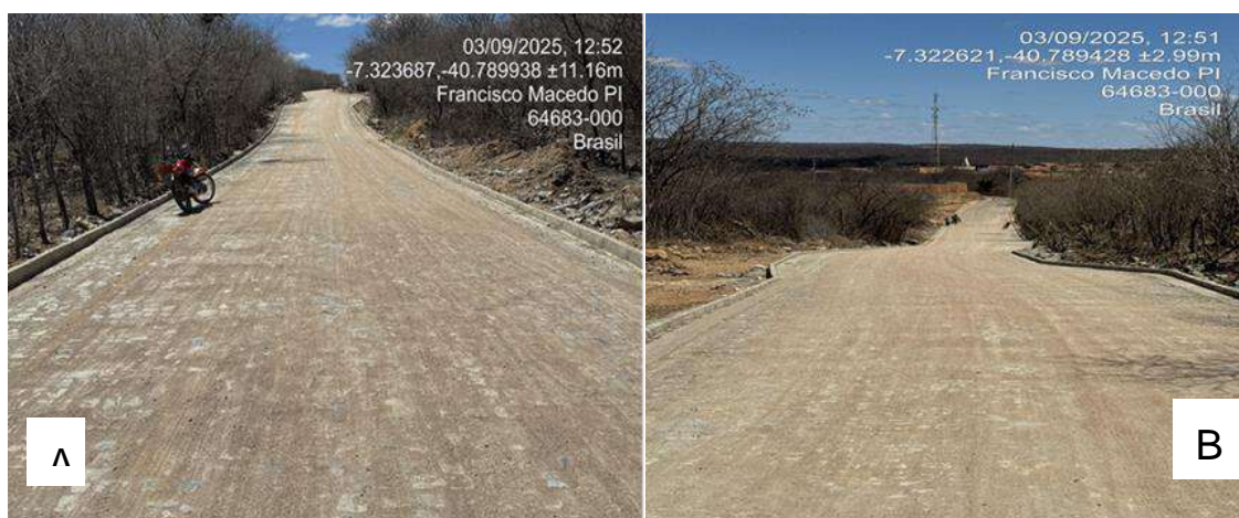
Figura 55 (A e B) - Pavimentação Poliédrica nas Comunidades Arapuá e Camboeiro, zona rural do Município de Francisco Macêdo-PI.
