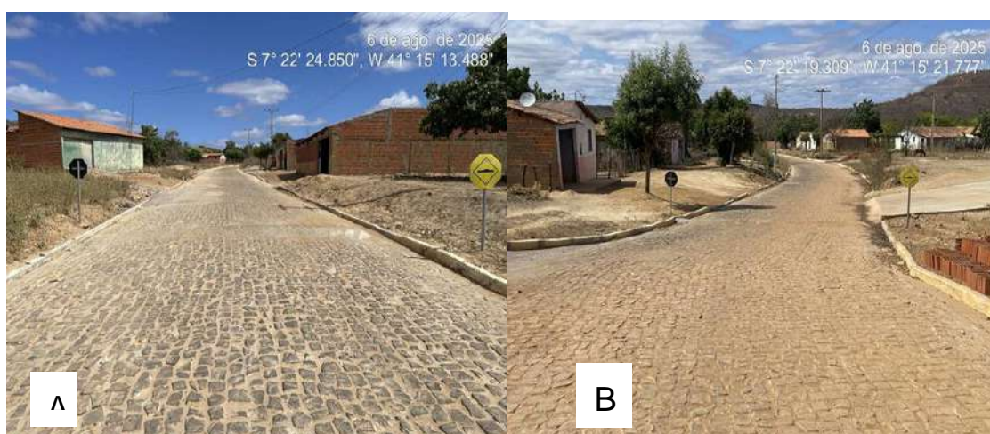
Figura 67 (A e B) - Pavimentação Poliédrica nos Povoados Gameleira e Esquizito, zona rural do Município de Jaicós-PI.
