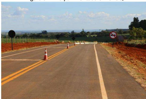
Figura 51 - Via pavimentada em CBUQ
