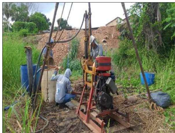
Foto 4: Execução dos ensaios SM – Sondagem Mista.
