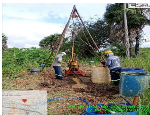
Foto 2: Execução dos ensaios SM – Sondagem Mista.
