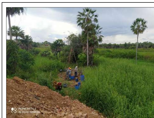
Foto 1: Execução dos ensaios SM – Sondagem Mista.
