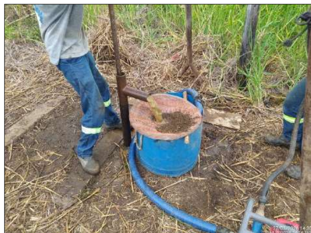
Foto 3: Execução dos ensaios SM – Sondagem Mista.
