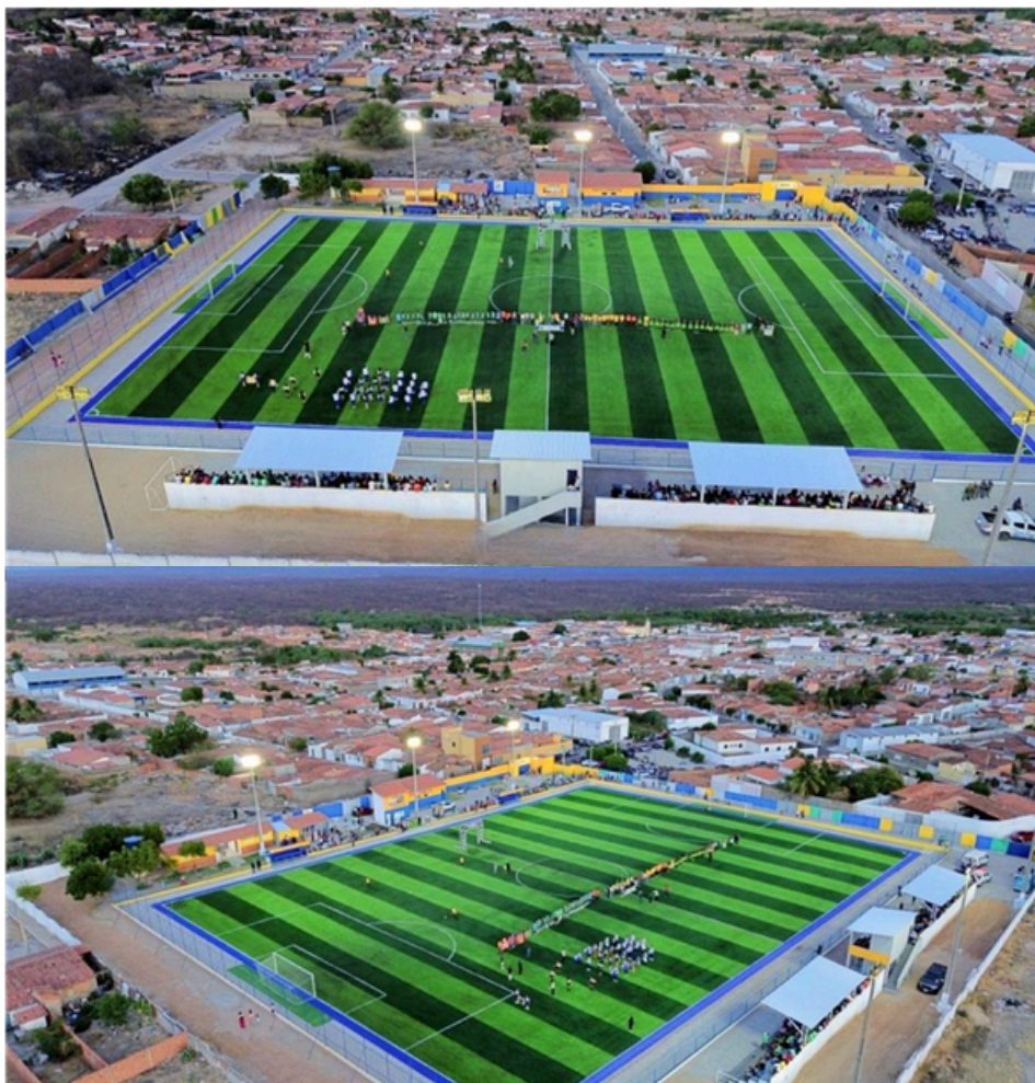
Figura 1 - Construção de estádio de futebol em Padre Marcos
