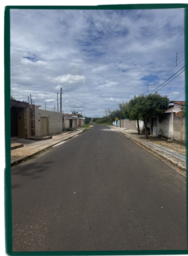
Pavimentação asfáltica no município de Picos
