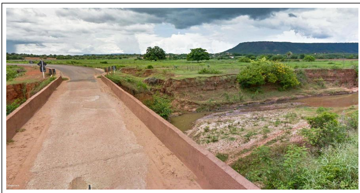
Figura Nº 26: Erosão e assoreamento do leito do córrego, afluente do rio Piauí, imediatamente a montante da cidade de Santa Rosa do Piauí. Destacam-se: 1- as ravinas profundas nas cabeceiras da ponte, induzidas pelo escoamento das águas da chuva pelo leito da rodovia, direcionadas para os terrenos laterais sem sistema algum de proteção; 2- Erosão lateral das margens do córrego totalmente desprovidas da vegetação ciliar original; e 3- bancos de areia assoreando o leito do córrego. (Street View, 02/2012)
