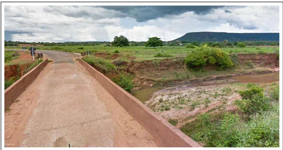
Figura Nº 26: Erosão e assoreamento do leito do córrego, afluente do rio Piauí, imediatamente a montante da cidade de Santa Rosa do Piauí. Destacam-se: 1- as ravinas profundas nas cabeceiras da ponte, induzidas pelo escoamento das águas da chuva pelo leito da rodovia, direcionadas para os terrenos laterais sem sistema algum de proteção; 2- Erosão lateral das margens do córrego totalmente desprovidas da vegetação ciliar original; e 3- bancos de areia assoreando o leito do córrego. (Street View, 02/2012)
